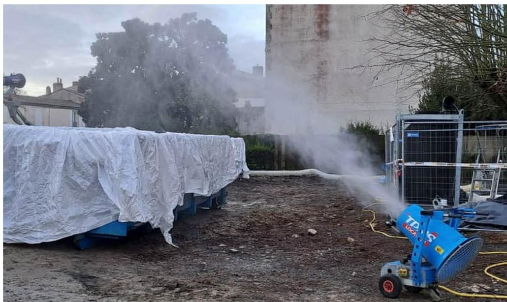
Figure 3 : Canons brumisateurs 20 m positionnés de chaque côté des bennes
